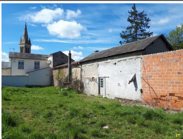
Photographie 1 : Vue du site vers le sud-ouest
