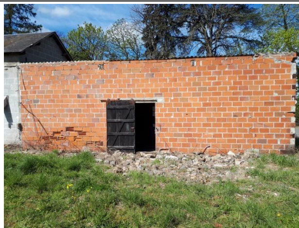
Photographie 2 : Vue de l'ancien atelier/entrepôt
