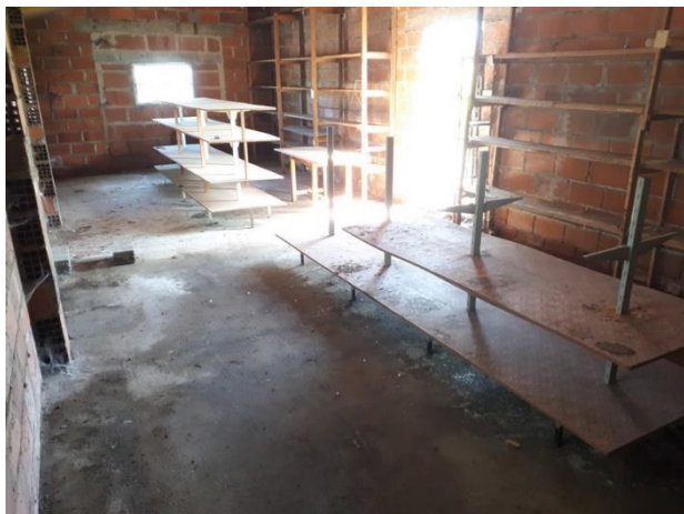
Photographie 3 : Intérieur de l'entrepôt inoccupé
