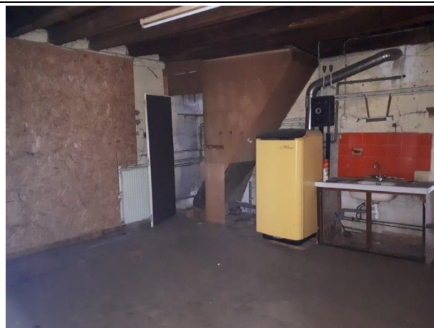
Photographie 4 : Vue de l'emplacement de l'ancienne chaudière au fioul sur vide sanitaire
