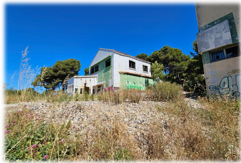
Figure 16 : Vue de l'emprise artificialisée en partie haute du site, caractérisée par des bâtiments désaffectés et des remblais de gravier grossier.
