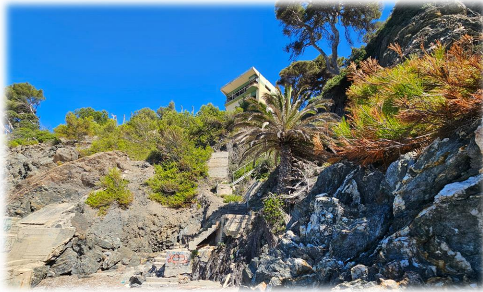
Figure 15 : Vue depuis le littoral rocheux en contrebas du site, montrant le promontoire escarpé sur lequel se situe l'ancien bâtiment.
