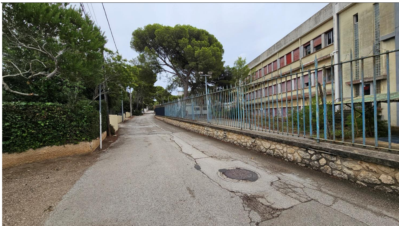
Figure 3 : Relevé des bâtiments depuis le Chemin de la Gardiole
