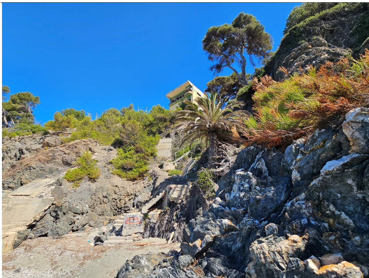
Figure 7 : Sur la plage, l'escalier d'accès
