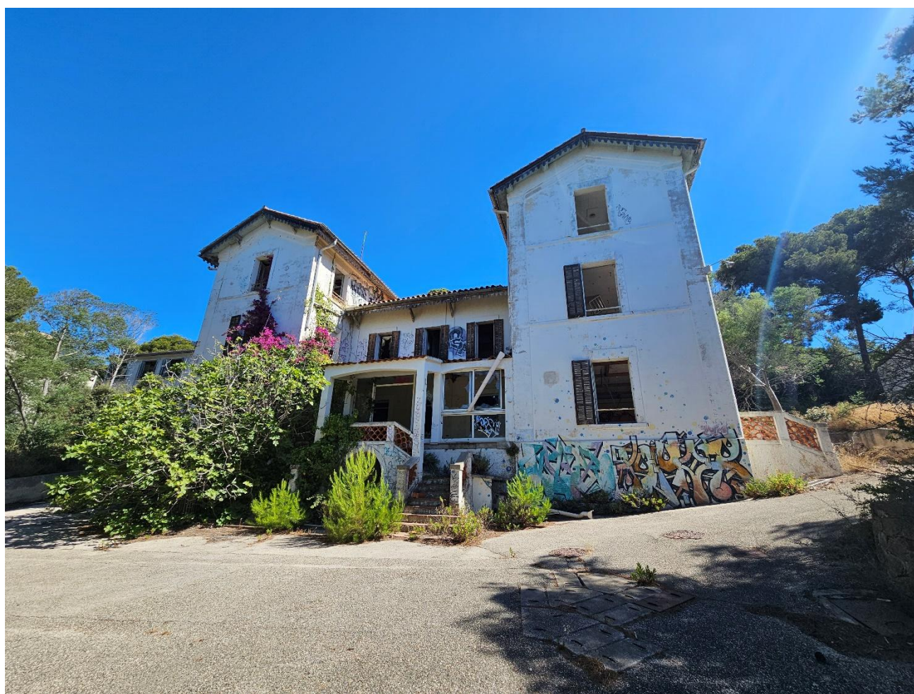
Figure 2 : Vue du bâtiment 4 conservé
