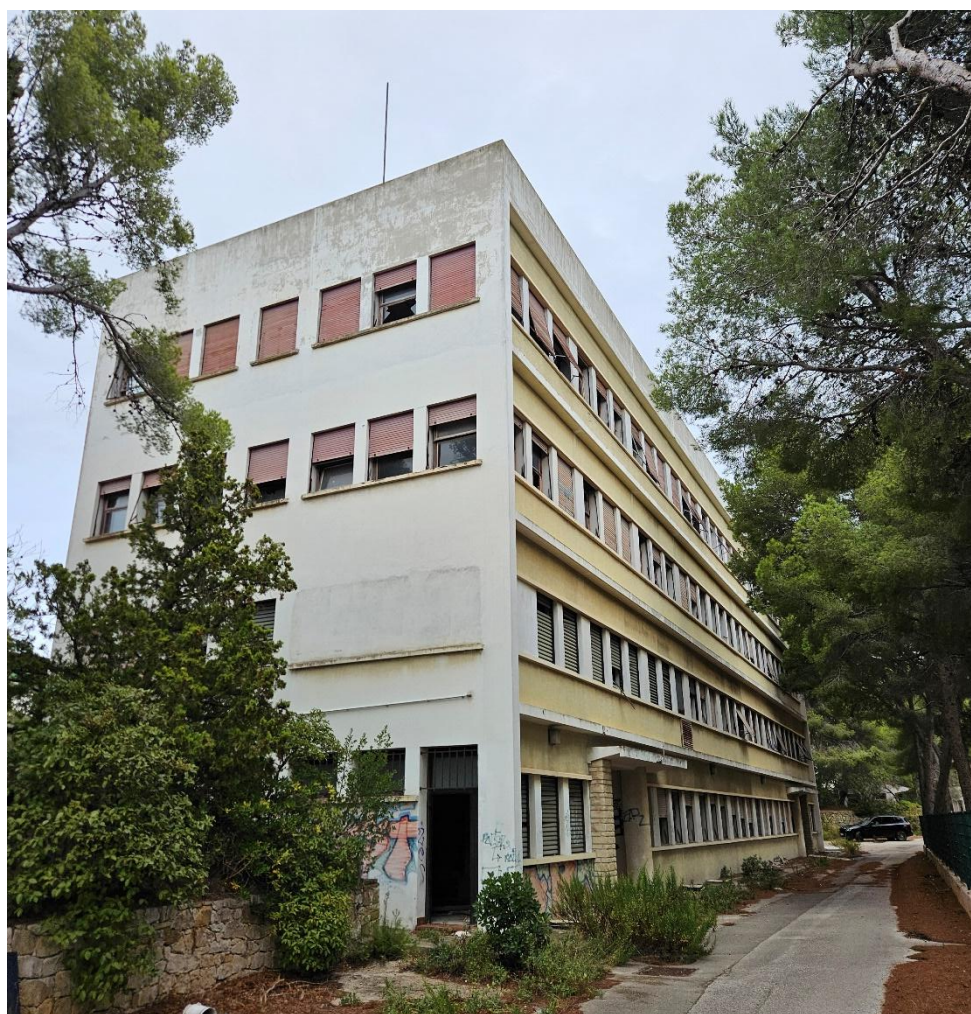
Figure 4 : Vue du bâtiment 1 coté intérieur. Sud
