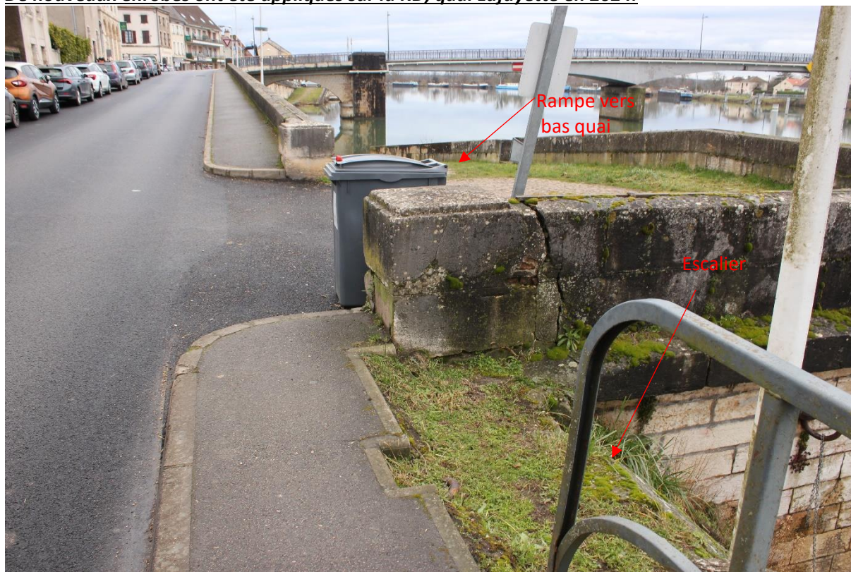
Photo 5 - Vue du raccordement du cheminement existant avec le bas quai, avec escalier
