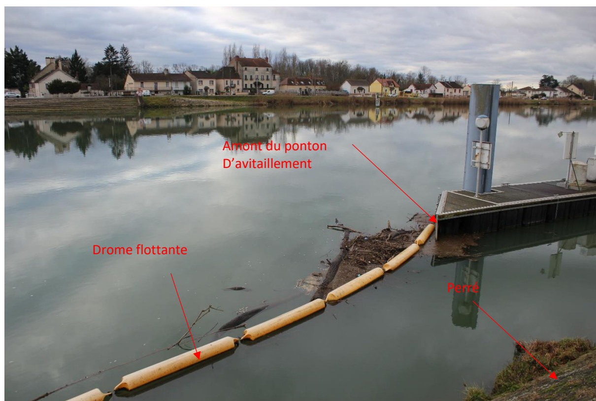
Photo 3 - Vue de la drome de la station d'avitaillement 23-01-2025
