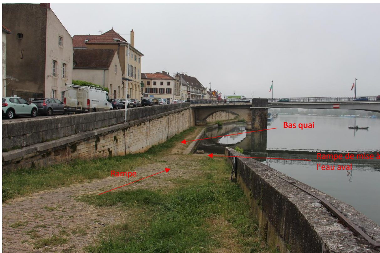
Photo 7 - Vue de la rampe vers le bas quai
