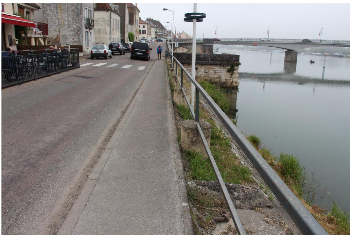
Photo 4 bis - Vue du cheminement piéton existant et du perré photo 2022
