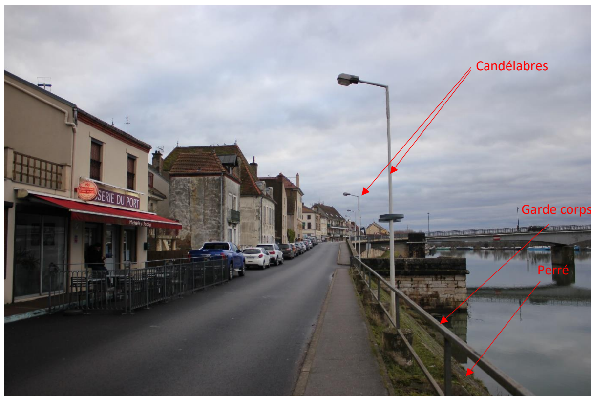
Photo 4 - Vue du cheminement piéton existant et du perré 23-01-2025
