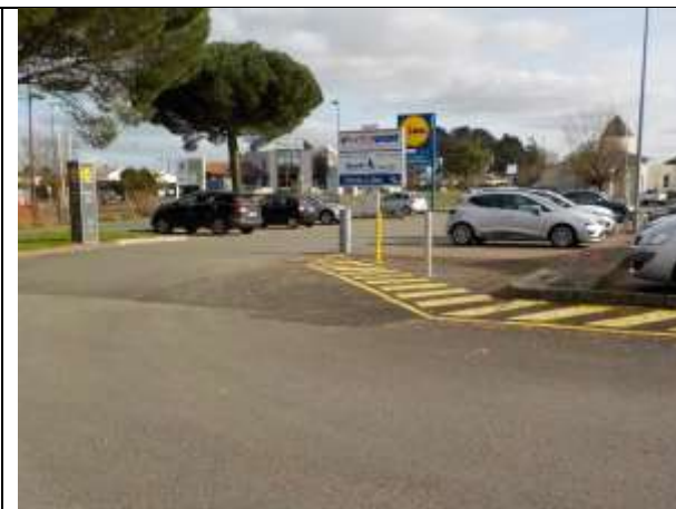
Autre vue de l'entrée centrale du parking
