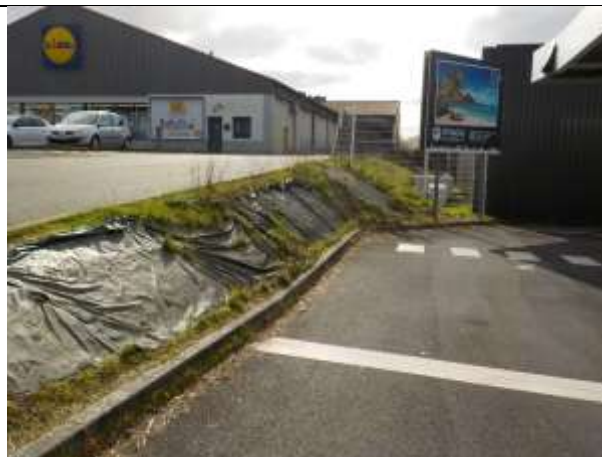
Talus côté Nord en limite de propriété
