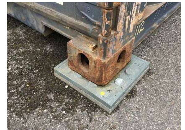
Pose sur dalle, pas de fondation
