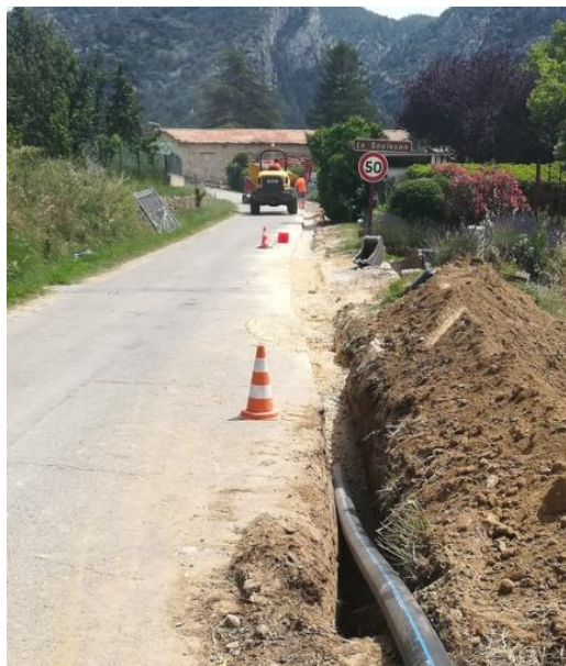
Pendant les travaux de pose
