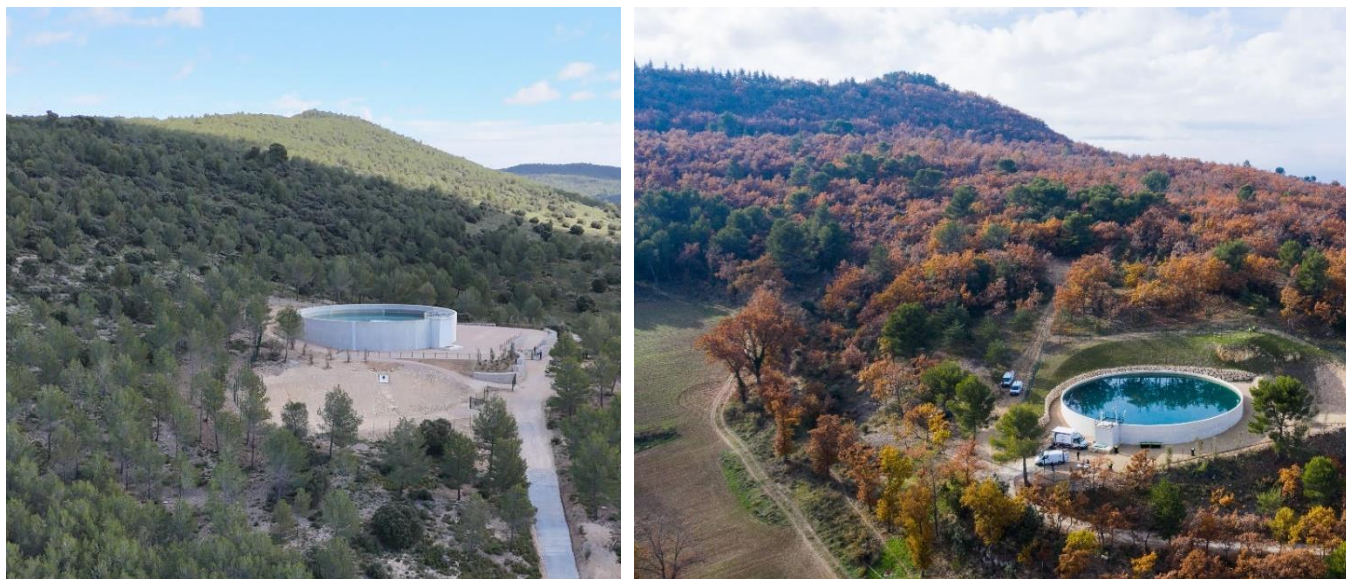
Figure 7. Vues sur des réservoirs similaires (Mirabeau 2024 et Apt 2021)
