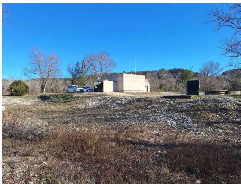
Figure 8. Station de pompage à renforcer
