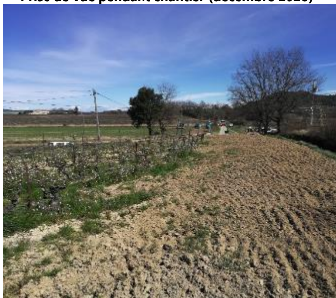
Prise de vue pendant chantier (décembre 2020)
