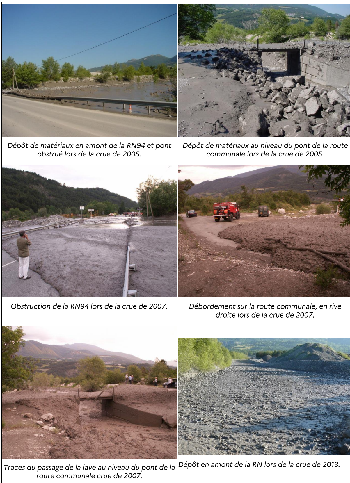
fig. 3 : photographies des dégâts/perturbations causés par les crues de 2005, 2007 et 2013
