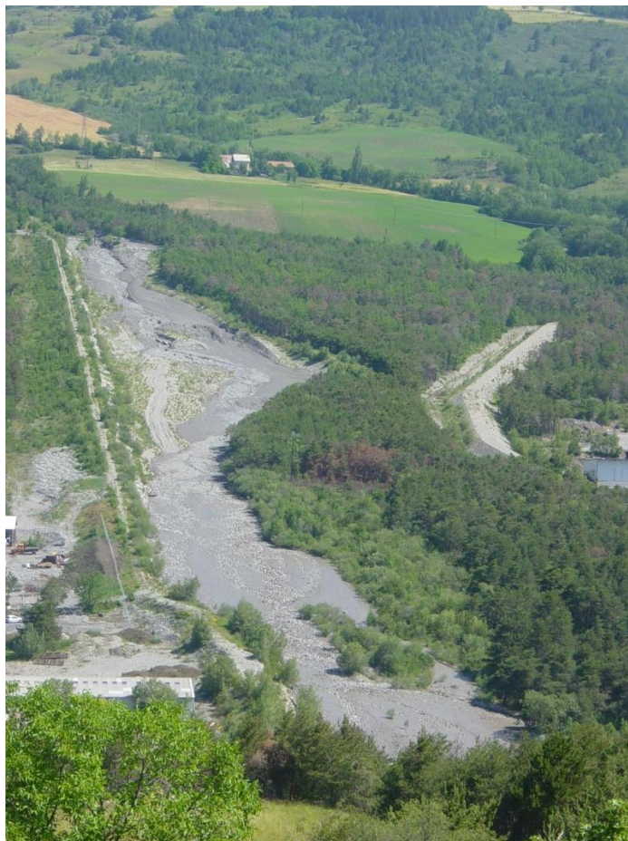
fig. 21 : Engravement du chenal en amont de la RN94 lors de la crue de 2005
