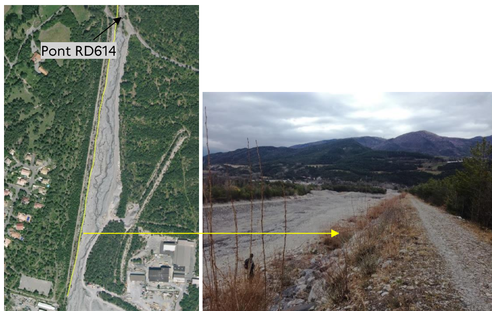
fig. 15 : risberme en rive droite au niveau de la digue aval
