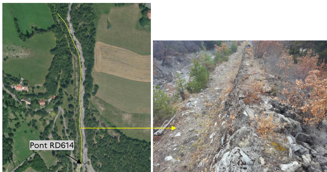
fig. 8: Risberme en rive droite à conserver
