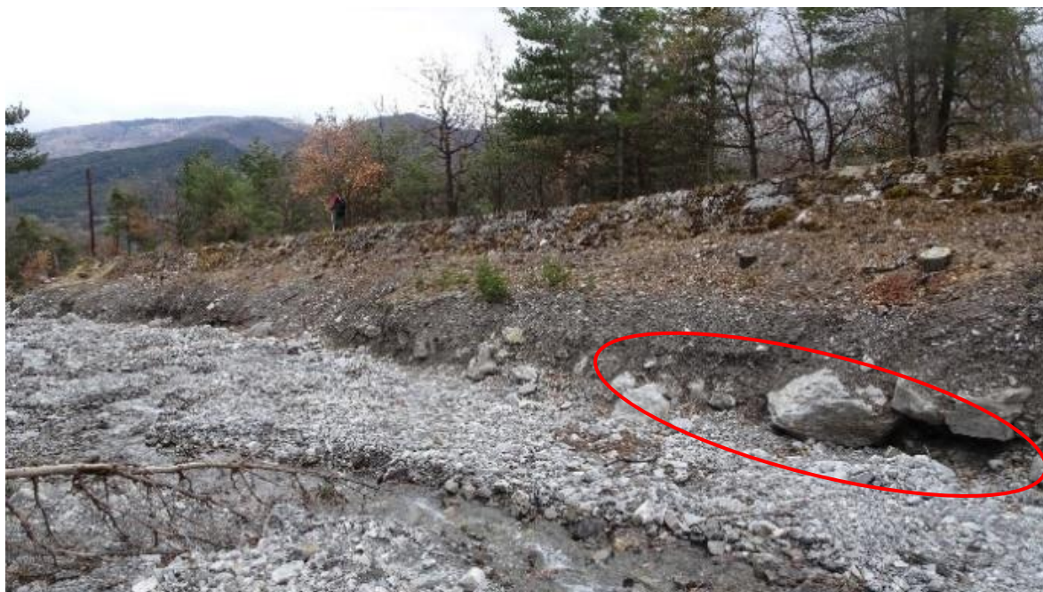
Figure 5 : Tronçon 1 de la digue amont vue depuis le lit du torrent.
