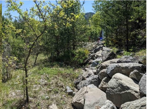
Enrochement en bordure est de la zone d'activité au centre du site
