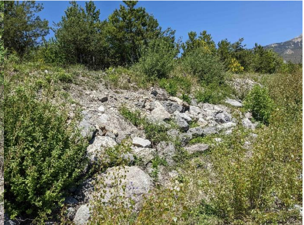
Enrochement de la digue en rive droite du Dévezet (moitié sud)
