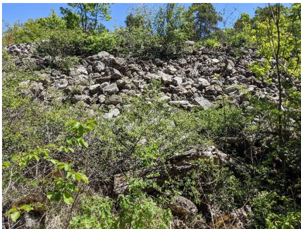
Enrochement de la digue en rive droite du Dévezet en amont du pont de la D614 (versant ouest)
