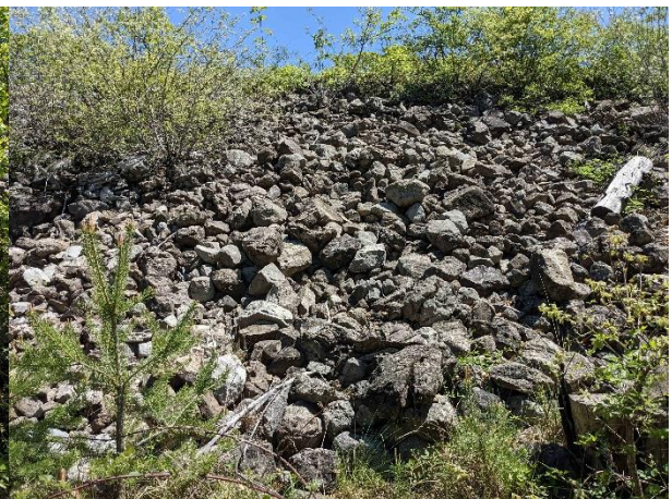
Enrochement de la digue en rive droite du Dévezet en amont du pont de la D614 (versant ouest)
