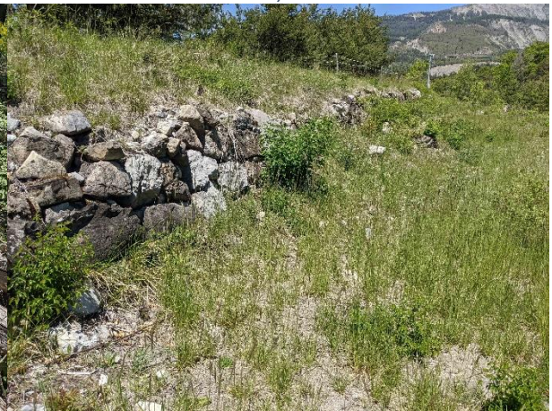
Muret en rive droite du Dévezet en amont du pont de la D614
