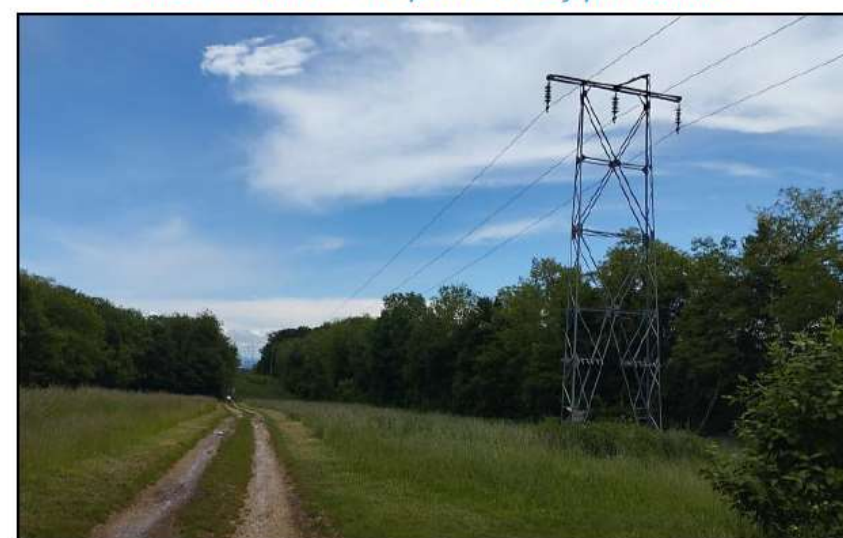
5 – Ligne aérienne existante et le chemin carrossable à emprunter au sein des Monts-de-Gy
