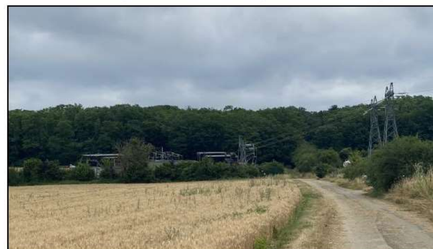
3 – Chemin d'accès au poste de Gy par le nord
