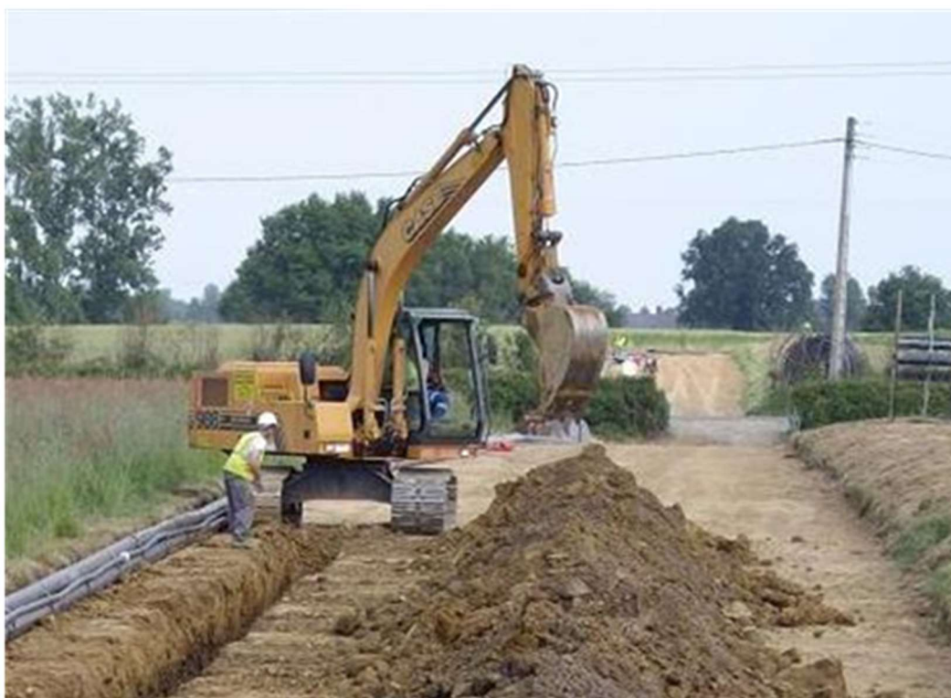
Figure 7 : Passage des lignes souterraines en phase travaux
