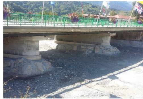
Reprise des piles et culées du pont d'Englannaz
