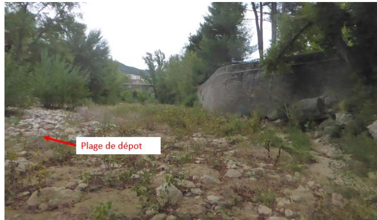
Environnement du mur du camping
