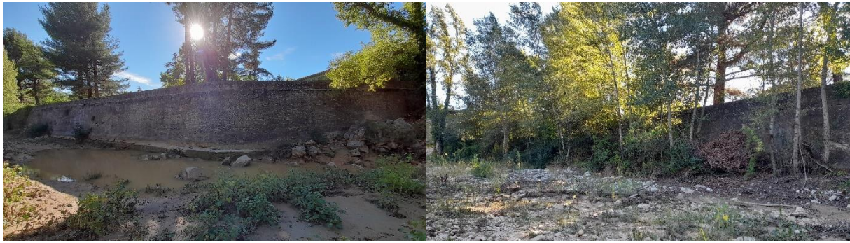
Mur du camping
