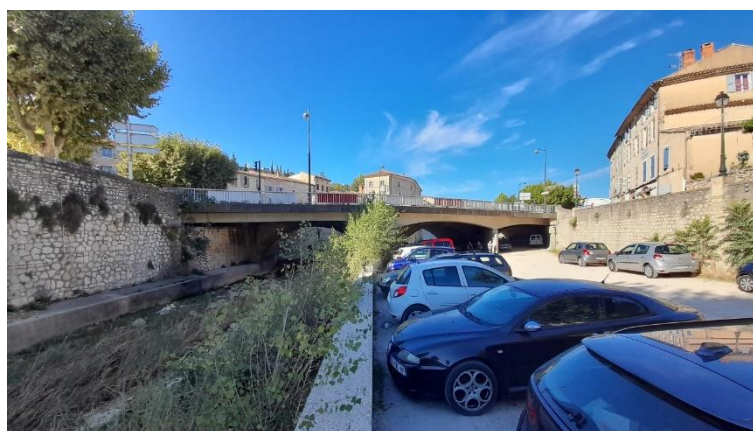
Figure 10 : Photographie (vue vers l'aval) et profil en travers de l'ouvrage du pont de la Bouquerie
