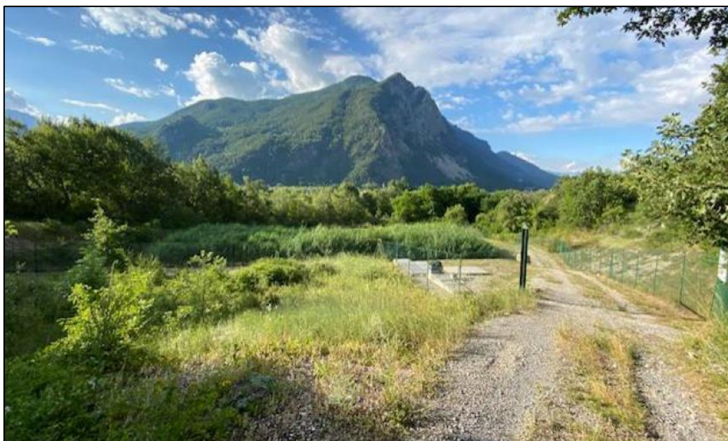
Figure 8: Station d'épuration du chef-lieu de Réotier
