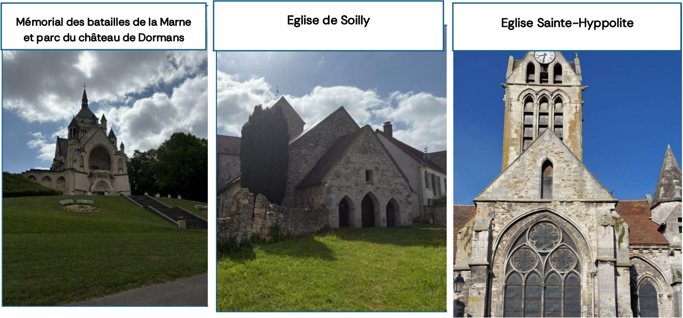
Figure 56 : Photographies du patrimoine bâti (Source :Visite de site du 22 mai 2025, Electricité d'Azur)
