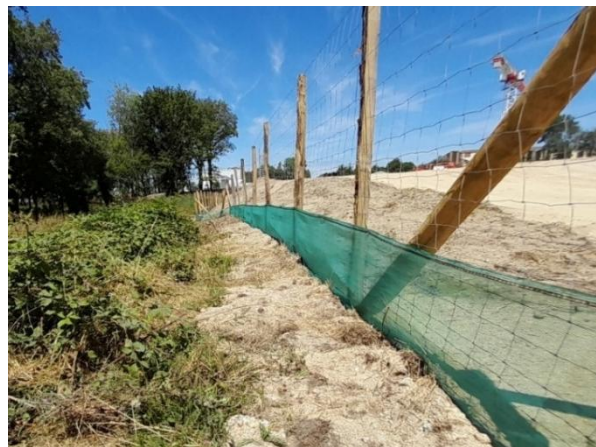
Figure 3 : Exemples de filets de protection pour limiter l'accès de la petite faune à un chantier (ENCIS Environnement)
