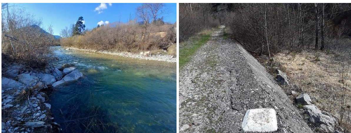
Figure 7 : Vues successives des aménagements en rive droite source du report des écoulements en RG puis de la protection de berge en RG liée à la traversée du pipeline (AMETEN, 2023)
