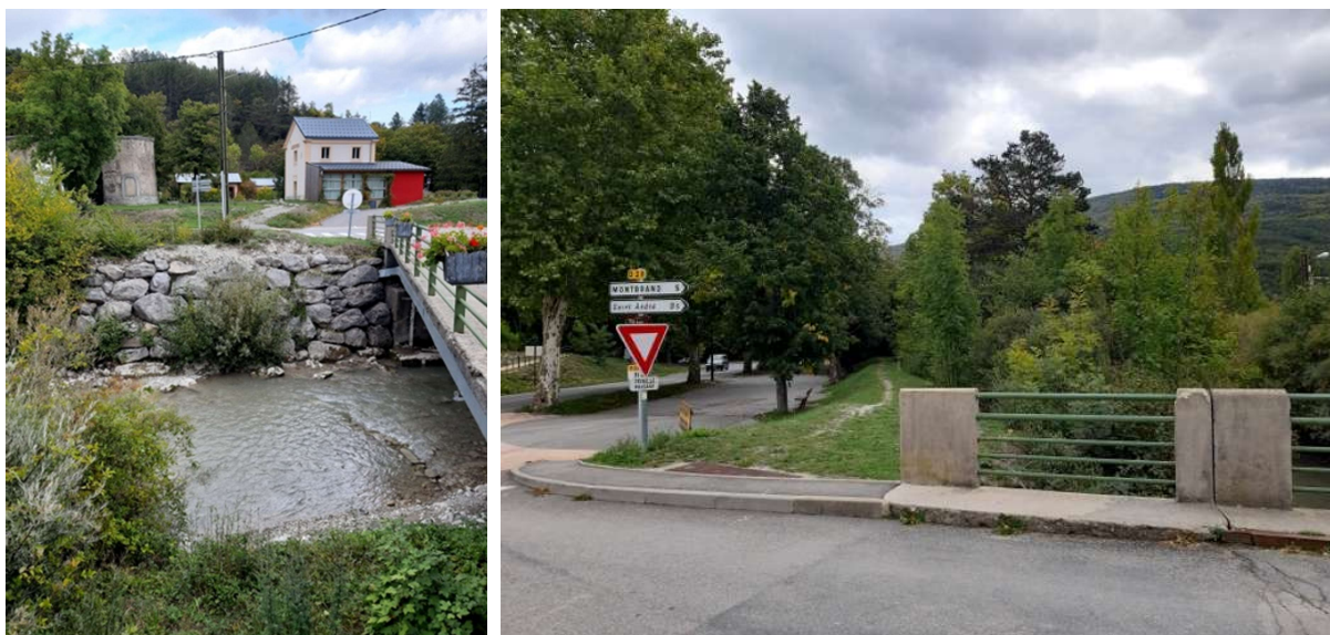
Figure 31 : Espace existant en rive gauche à requalifier entre le futur pont St André et la RD.
