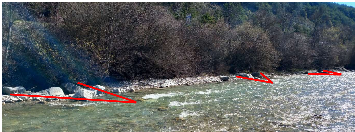
Figure 4 : Anciens épis protégeant la rive gauche dans la zone de contraction imposée par la digue Levas (AMETEN, 2023)
