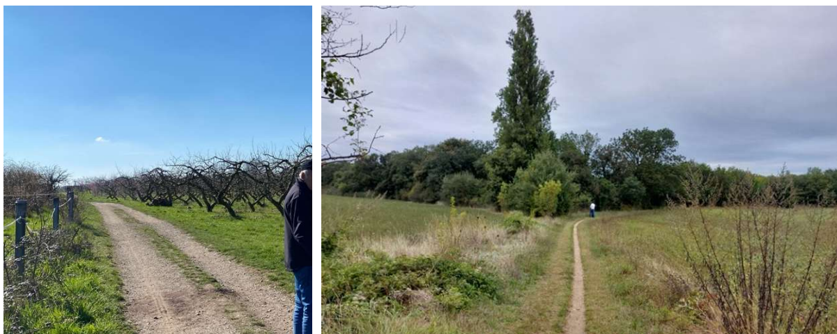
Figure 22 : 1- Exemple de piste carrossable en mélange terre-pierre. 2 - chemin piéton en terre battue
