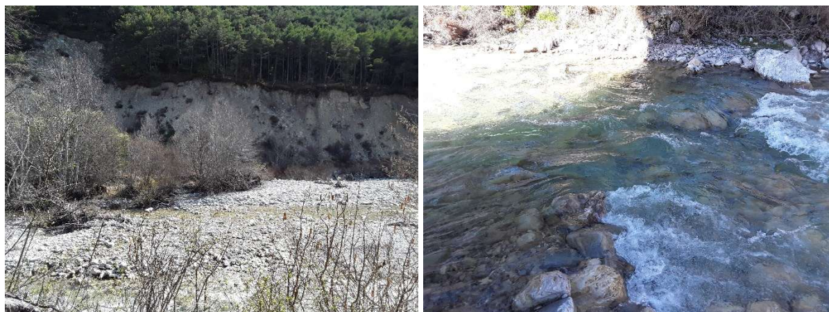
Figure 8 : Front d'érosion du versant du Bois des Faures et seuil en aval du pont de Seilles (AMETEN, 2023)
