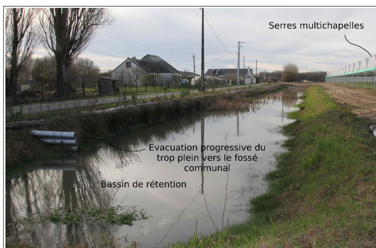
Exemple de bassin de rétention (photo prise sur un autre site)
