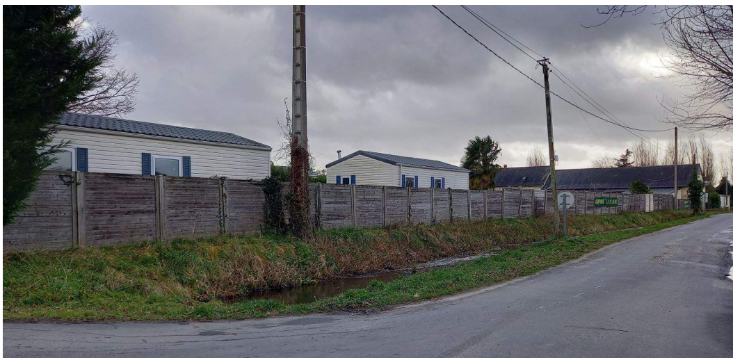
Point de vue 1 : vue sur la clôture du camping en arrivant sur la route du Pô. Les serres ne font pas face à cette clôture, mais se situent à plus de 140 m de cette zone.
