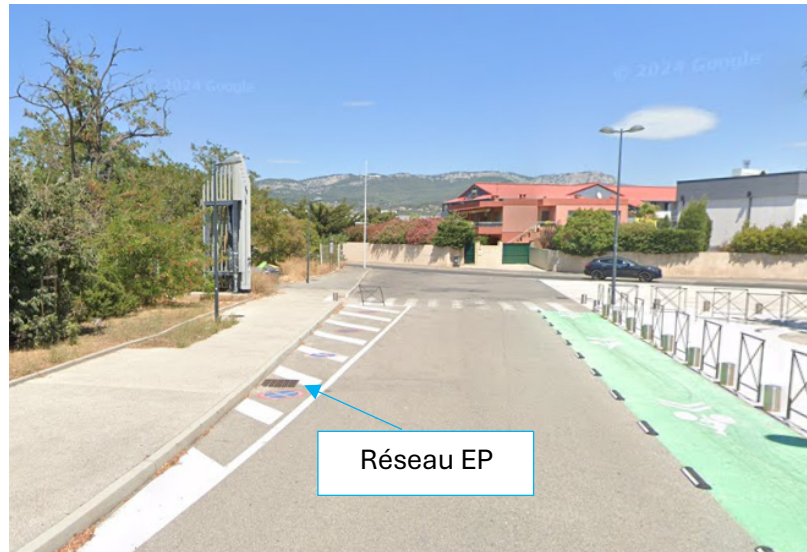
Photo 1 : Réseau EP entre le site d'étude et le Parvis, côté Est
