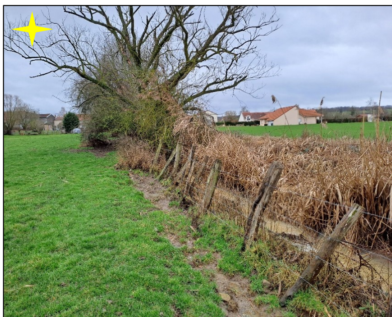
Vue limite de parcelle le long du ruisseau vers le sud-est
