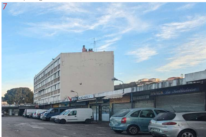
Rez-de-chaussées commerciaux vieillissants à Kallisté, 01/24
