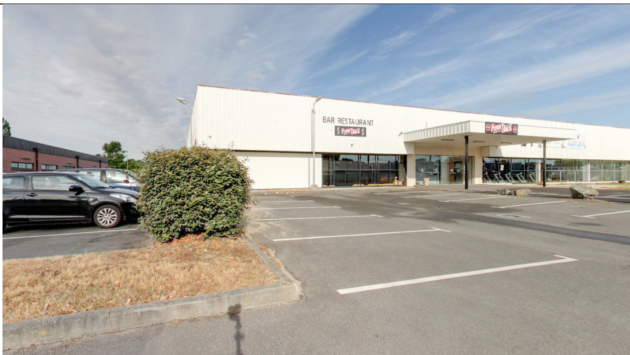
3 : Vue du bâtiment à démolir depuis le parking le long de l'avenue de Bretagne
