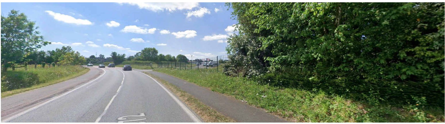
PHOTO n° 3 : Vue depuis le NORD - Route D 972 - Photo prise en Mai 2025
