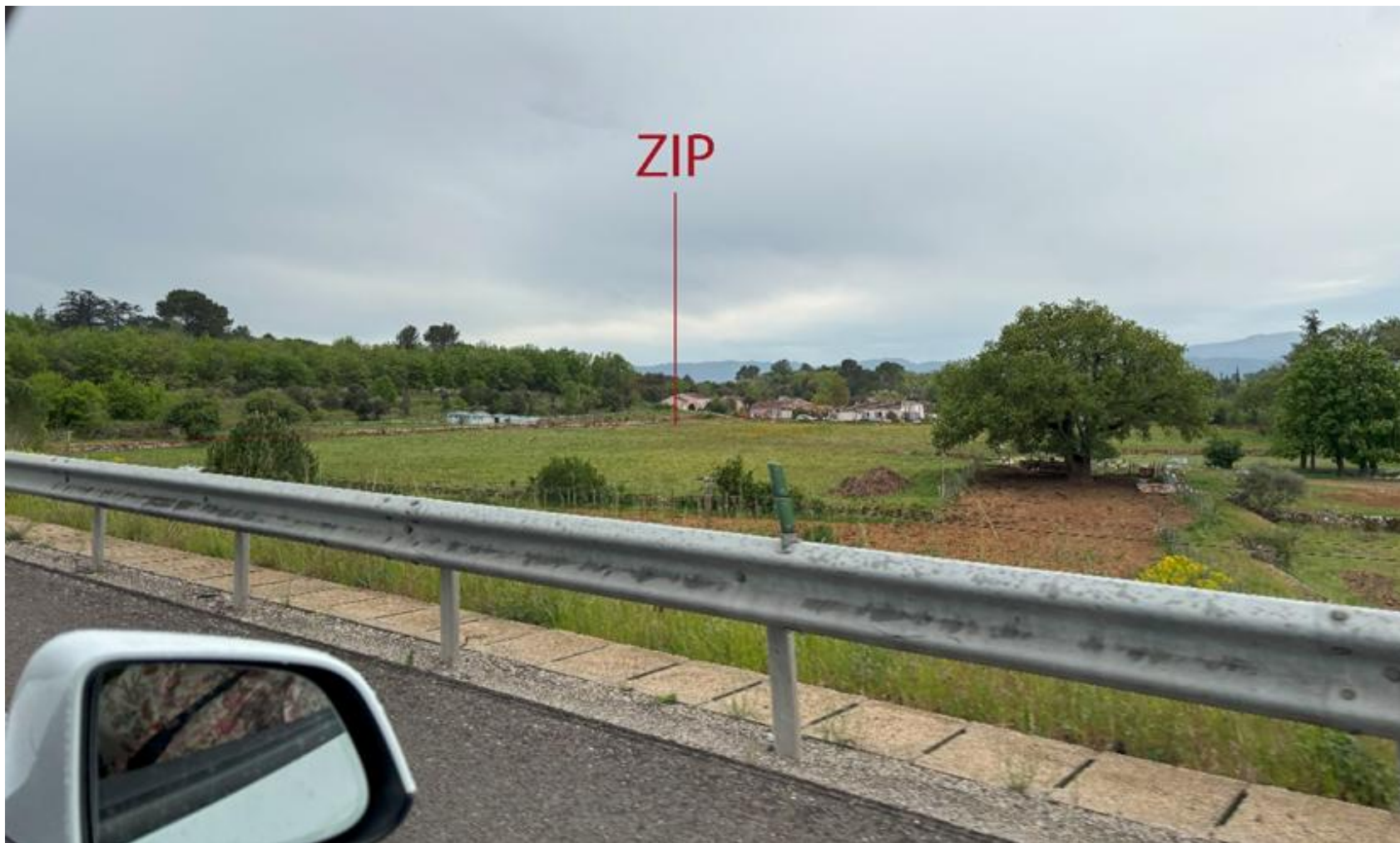
Vue 3 : Vue depuis A8 dans le sens de circulation Aix-Brignoles au niveau de la ZIP
