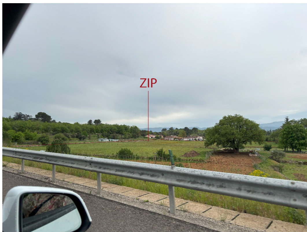
Figure 20 : Vue depuis l'A8 dans le sens de circulation Aix-Brignoles au niveau de la ZIP
