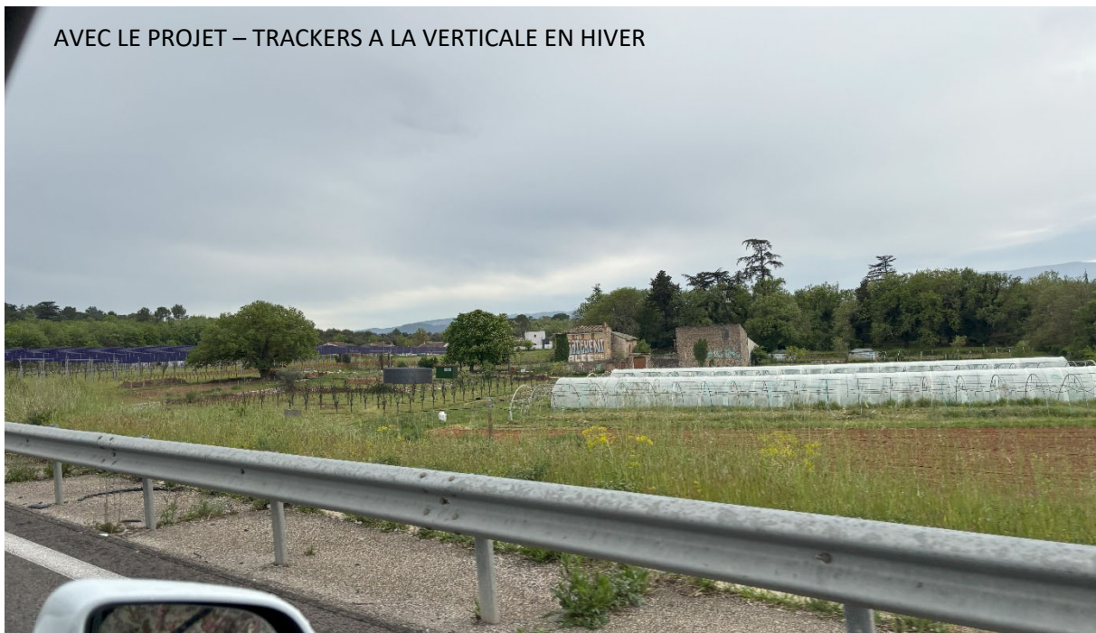
Figure 38 : PM2 - Avec le projet (ombrières PV et zone témoin arboricole au premier plan de la citerne) – Trackers à la verticale en période hivernale
