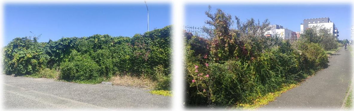
Figure 3 : Illustration du talus herbacée à gauche et du talus colonisé par de jeunes ligneux à droite
