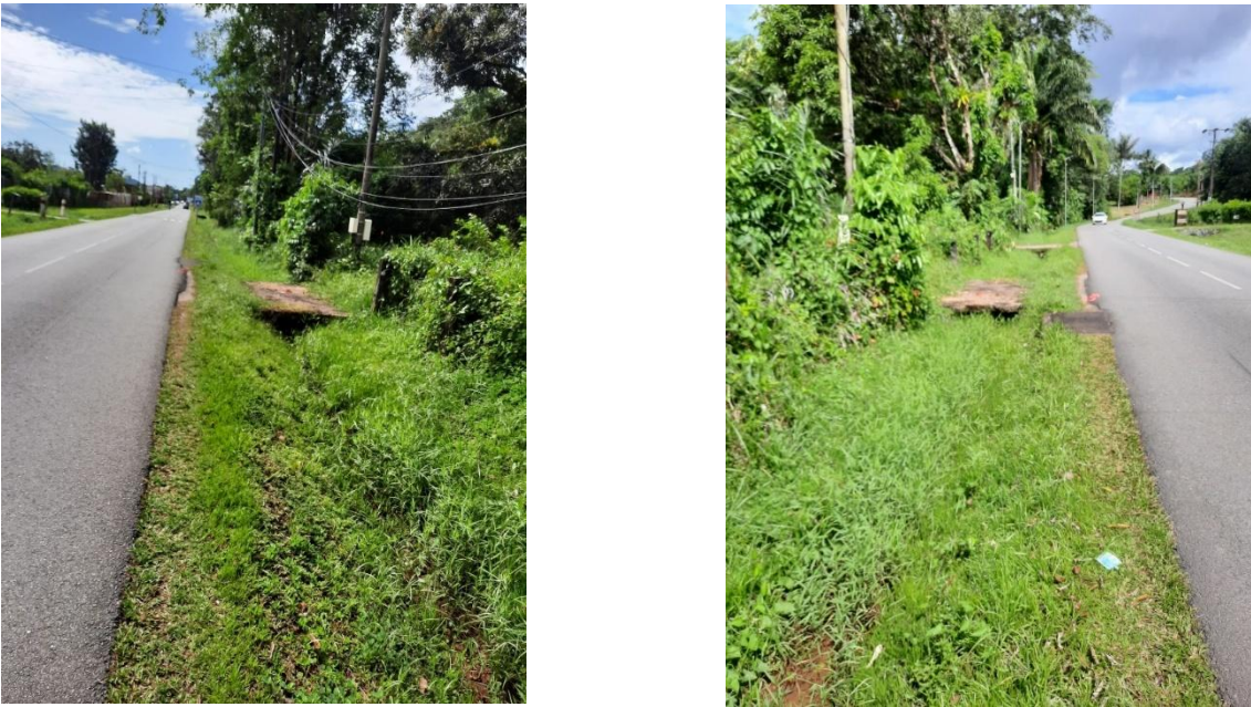
Figure 20: Photographies du fossé en lieu et place du futur passage busé pour voie d'accès
