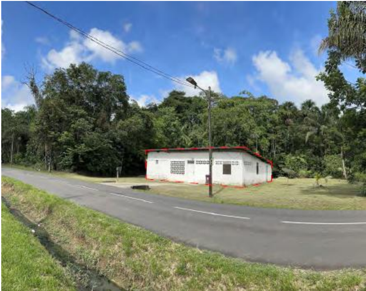
Figure 7 - Photographies de l'état initial de la parcelle projet
