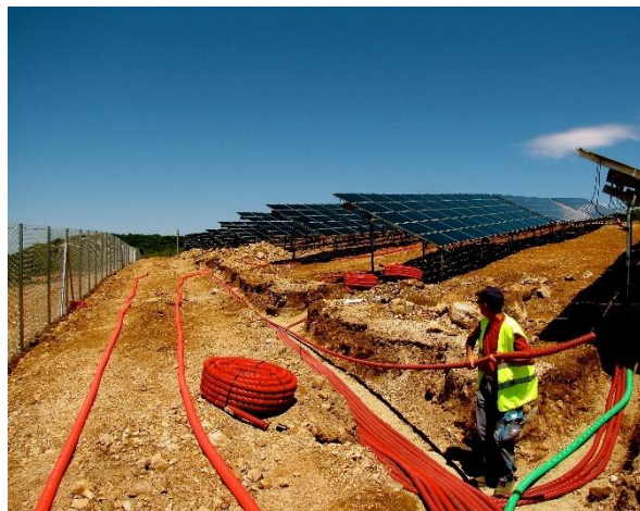
Photo 2 : Tranchées internes et gaines
