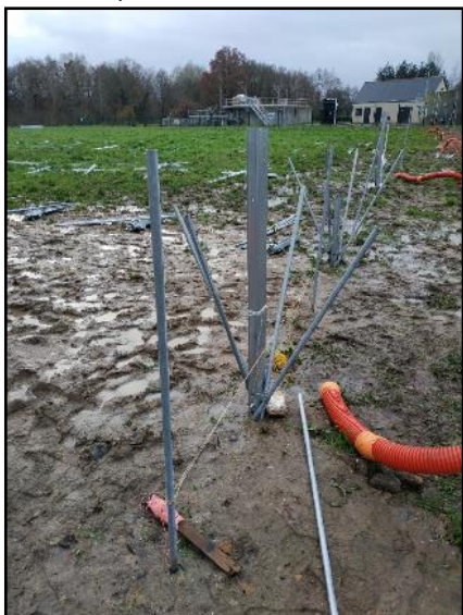
Photo 3 : Structures en micropieux, avant battage des micropieux - Parc solaire de Soucelles - 299 kWc
