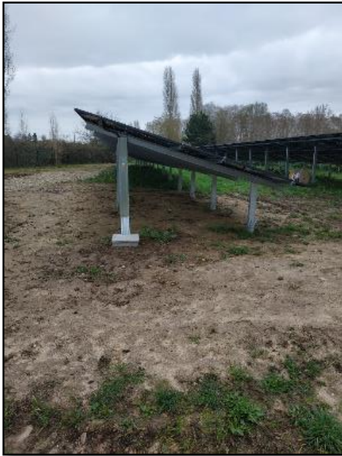
Photo 4 : Tables photovoltaïques avec structures en micropieux - Parc solaire de Soucelles - 299 kWc
