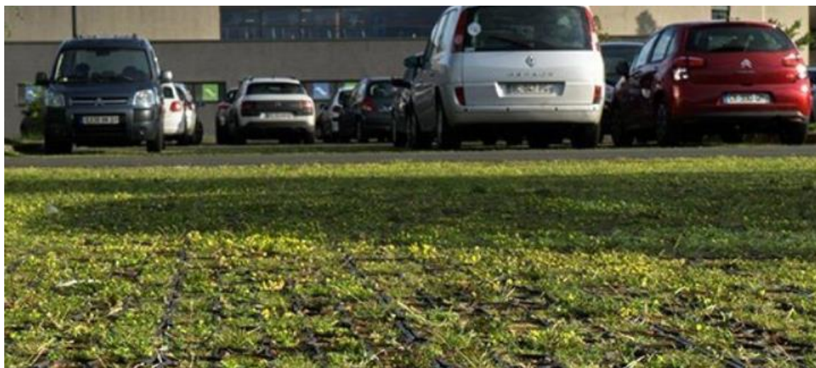
Figure 4 : Exemple de parking drainant végétalisé
