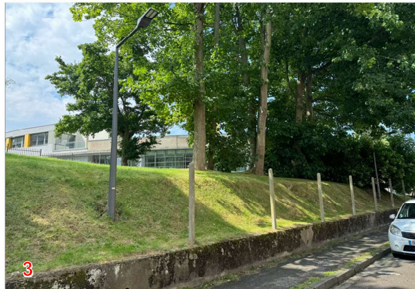
Vue sur le Centre aquatique depuis la rue des Murs Fontaine
