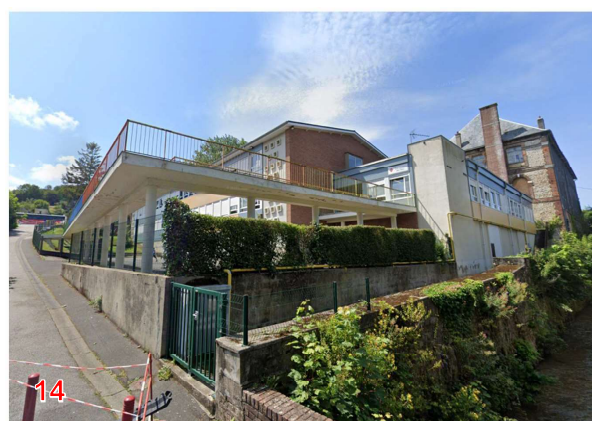
Vue sur les locaux de l'école maternelle Jean Macé depuis la rue des Murs Fontaine
