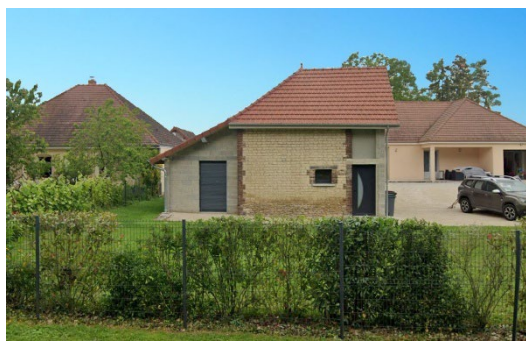
Réhabilitation et nouvelle construction au hameau
