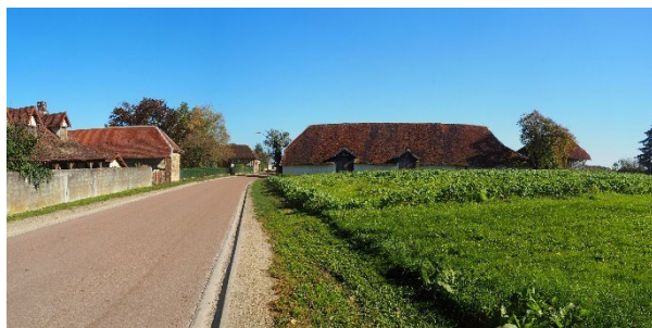
Coupure dans la trame bâtie partie Est – RD 123
