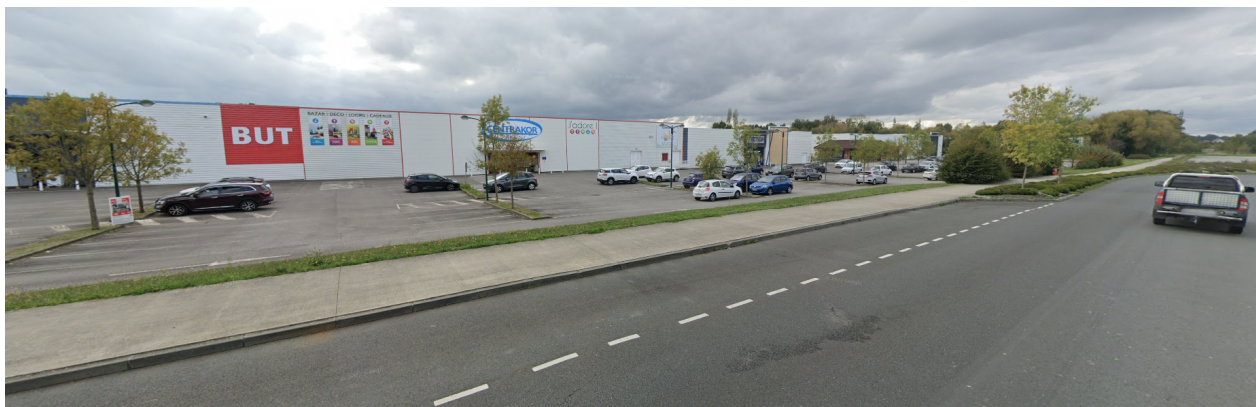
6 : Vue générale de l'environnement du site depuis la route de Pouancé : zone commerciale au Sud-Ouest
