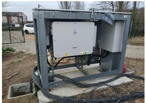
Figure 26 : Abri onduleurs
