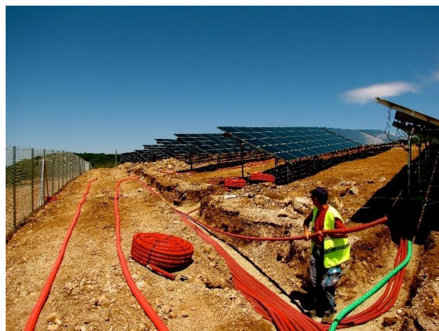
Figure 30 : Tranchées internes et gaines
