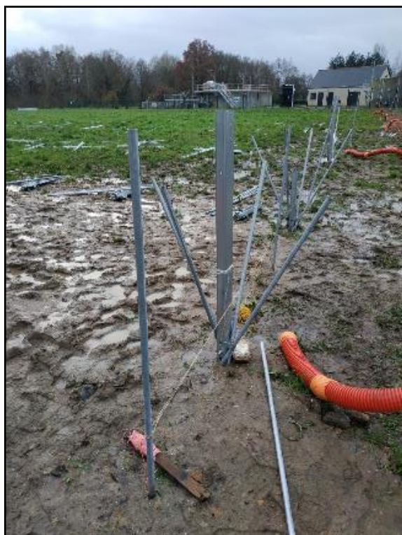
Figure 23 : Structures en micropieux, avant battage des micropieux - Parc solaire de Soucelles - 299 kWc
