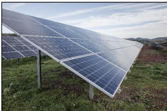
Figure 21 : Structures en pieux battus - Parc Solaire de Camares (12) - SDMD
