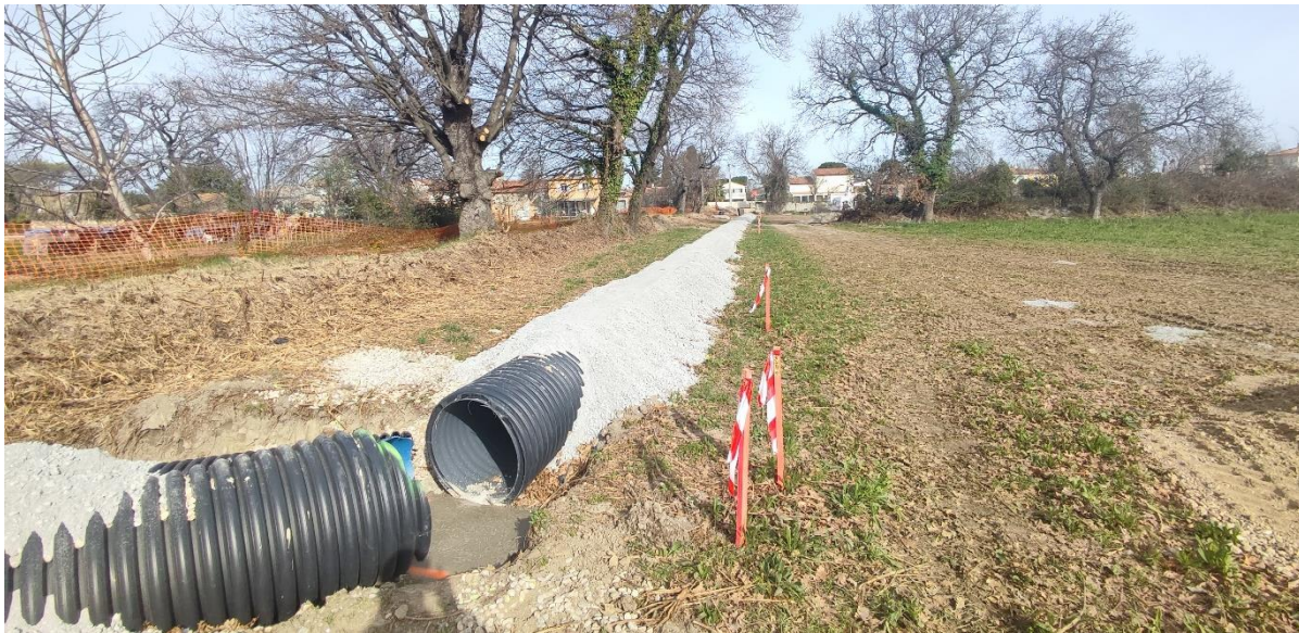
Figure 4. Travaux de canalisation du canal d'irrigation réalisés au nord de l'aire d'étude (Photo prise sur le site d'étude © S. Guiraudou / Naturalia).
