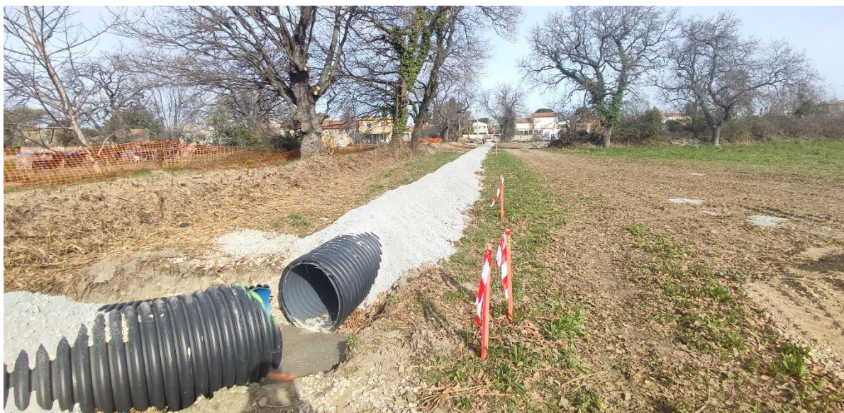
Figure 36. Rappel de l'illustration des travaux de canalisation du canal d'irrigation réalisés au nord de l'aire d'étude (Photo prise sur le site d'étude © S. Guiraudou / Naturalia).
