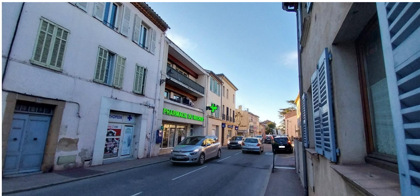
Photo 9 : Vue Ouest depuis la RD7 (Avenue du Général de Gaulle) – TPFi février 2024
