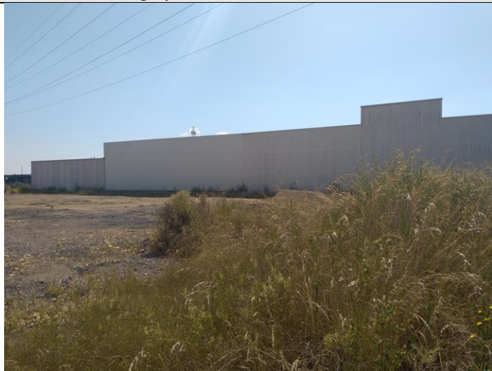
Photographie n°7 : vue sur l'est du site
