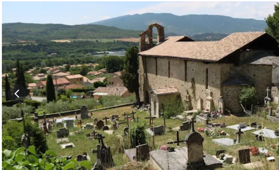
Photo 1 - Vue depuis les hauteurs de la chapelle
