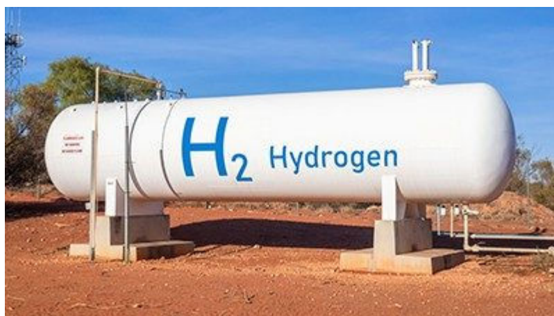
Figure 4 - Exemple d'une cuve de stockage hydrogène à 30 bars
