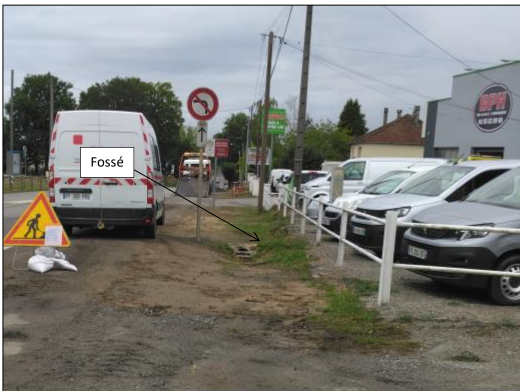
Figure 6 : Photo du fossé présent à l'avant du terrain
