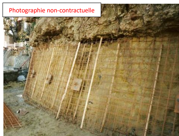
Figure 3 : Ferrailage paroi supérieur avec conservation banc gréseux
