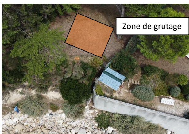
Figure 2 : Photographie de l'emplacement de la zone de grutage
