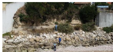
Figure 4 : Vue d'ensemble enrochement secondaire
