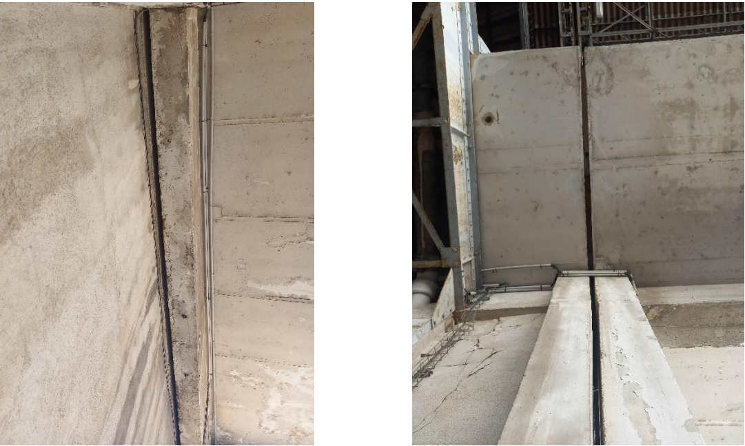
Figure 32 : Interstices entre deux volumes bétonnés, A. BARATEAU © EODD 2024
