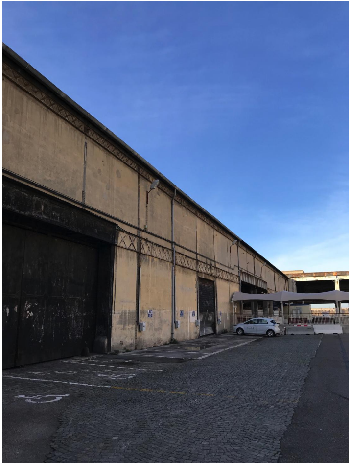
Façade Nord halle J0 - Etat actuel.
