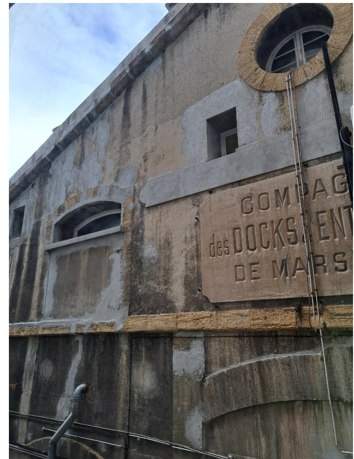
Façade est halle J0 - Etat actuel vu depuis la cour intérieure du siège du GPMM
