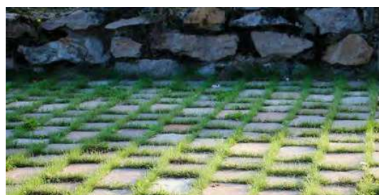
pavés joints engazonnés
