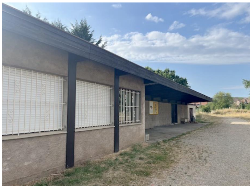
Figure 23 : Vestiaires-club house de l'ancien stade de Mittelbergheim.
