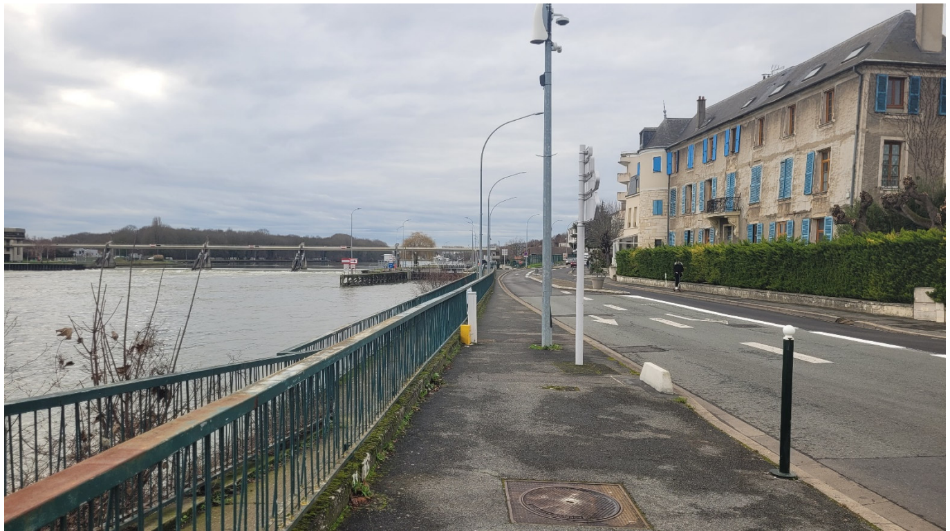
Photo 2 : promenade rive gauche aval de l'écluse
