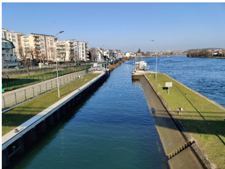
Vue générale vers l'aval du sas depuis la passerelle – RN aval
