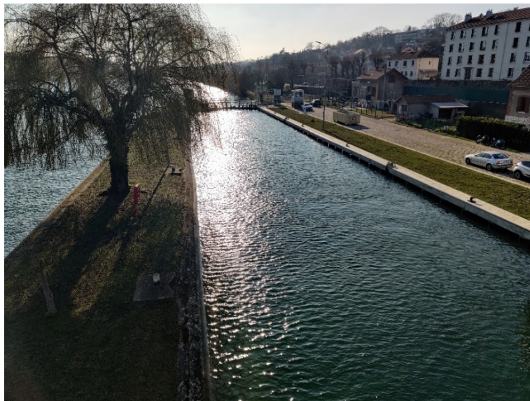
Photos 3 : vues générales sur l'écluse
