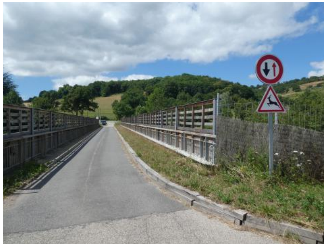
Aménagement d'un pont par la métropole de Saint-Etienne en 2016
