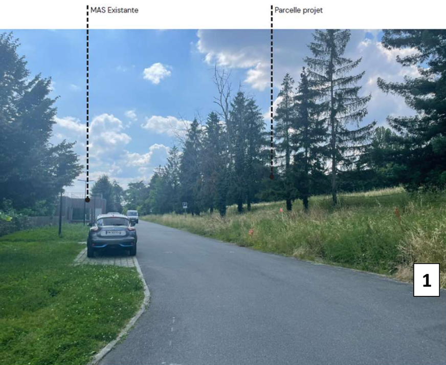
1: Voirie située entre la Maison d'Accueil Spécialisé (MAS) existante et la parcelle projet – Prise de vue vers le sud-ouest (Source: Permis de construire, Juillet 2025)
