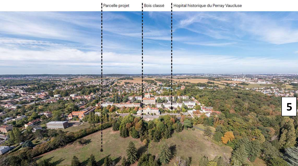
5: Parcette projet – Prise de vue aérienne vers le nord-ouest (Source: Permis de construire, Juillet 2025)
