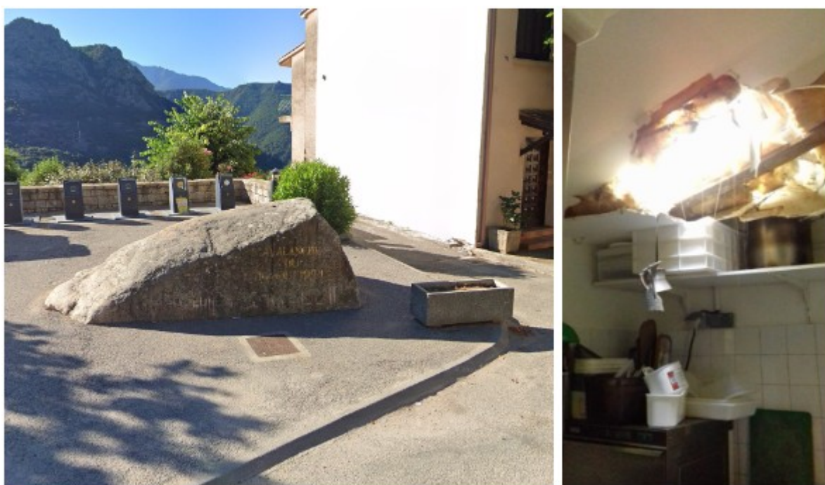
Figure 3 : À gauche, bloc témoin de l'éboulement de 1944, au cœur du village ; À droite, toiture du restaurant U Castellu impacté par une chute de bloc en décembre 2019.
