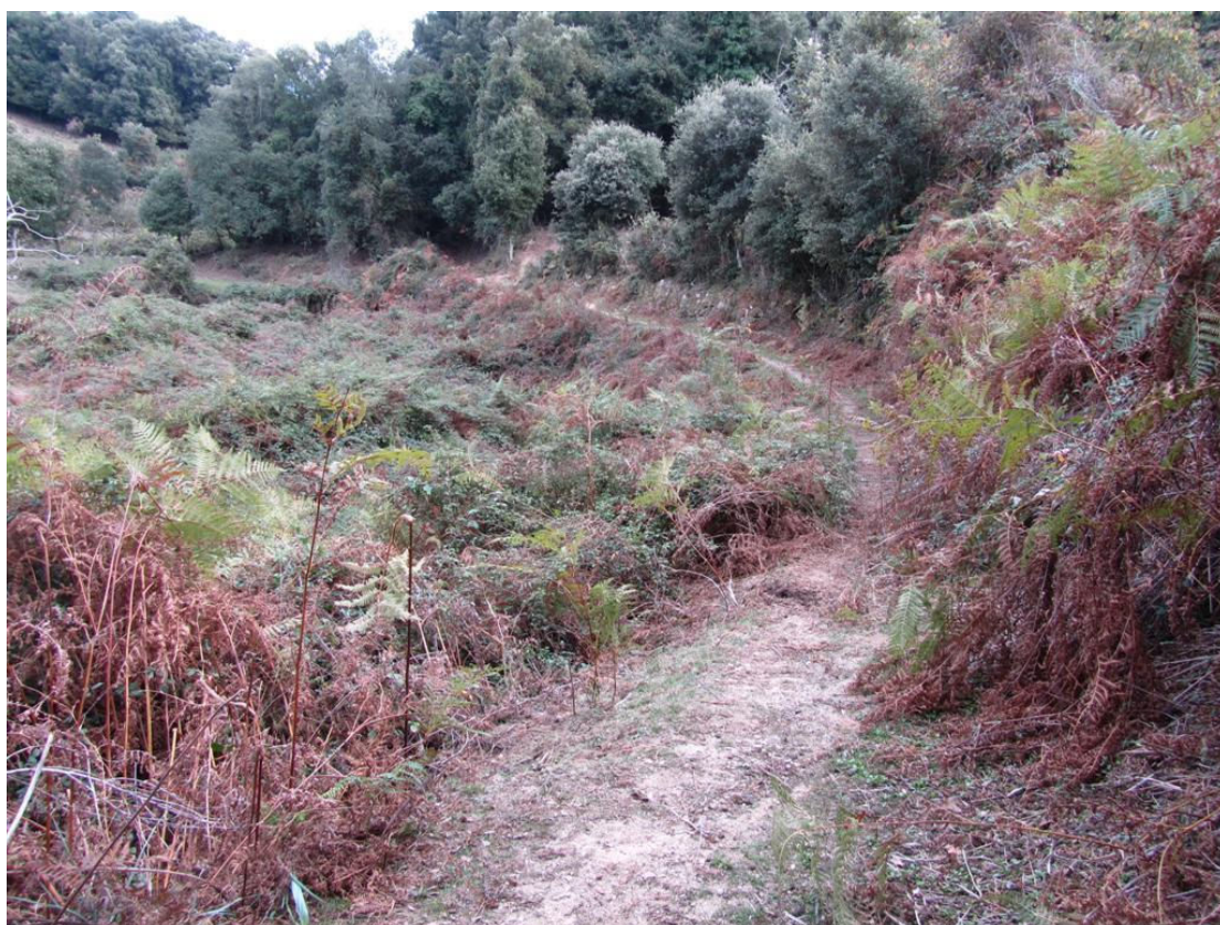
Piste d'accès au site : engins et réseaux
