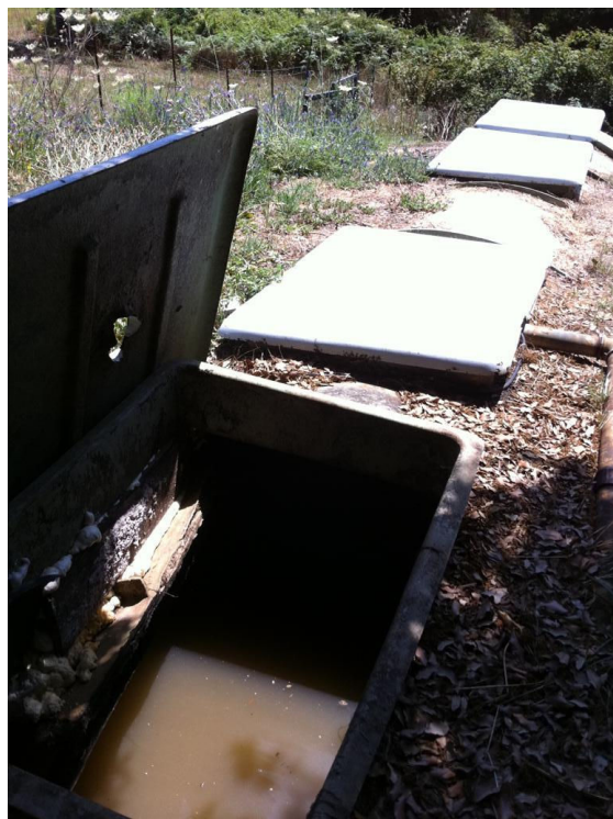
Illustration 2 : Bassins d'aération – Dégrilleur en entrée de station
