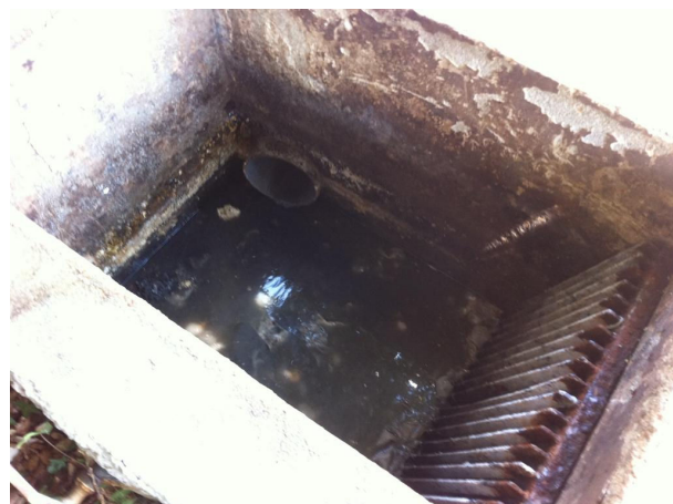
Illustration 2 : Bassins d'aération – Dégrilleur en entrée de station
