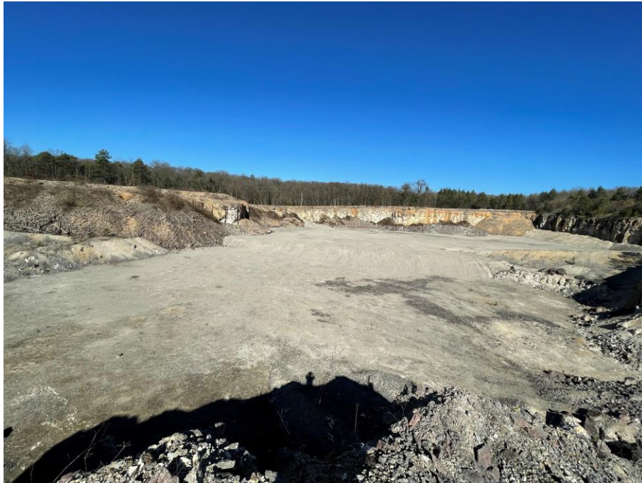
1 : depuis le sud de la carrière
